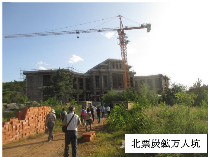
新記念館（資料館）を建設中
