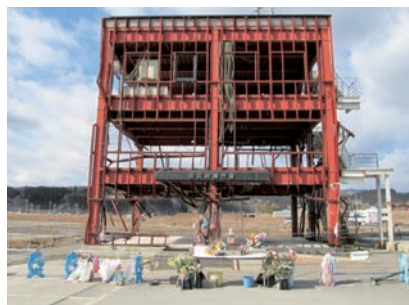
「防災対策庁舎（宮城県南三陸町）」
